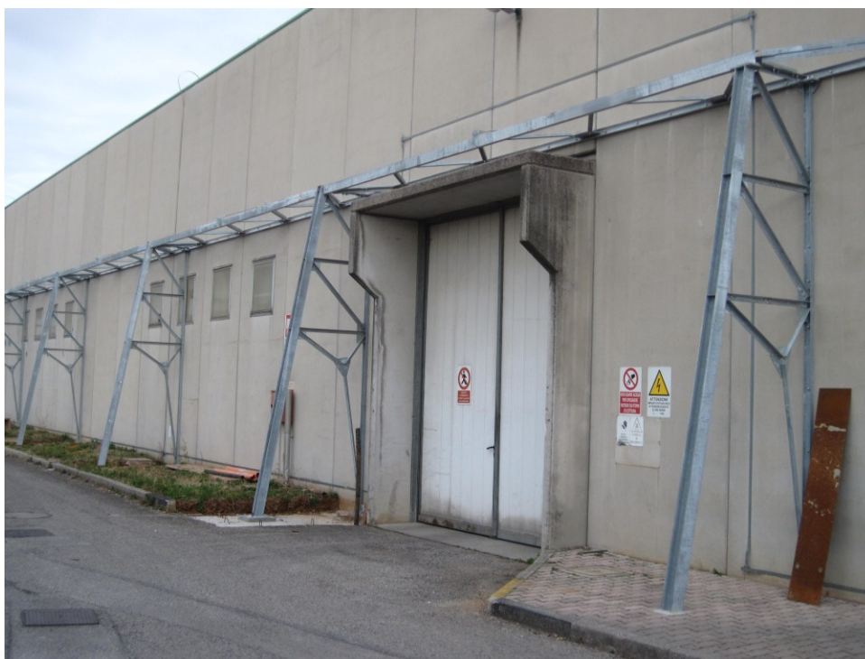
Figura 12: immagini della controventatura esterna.
