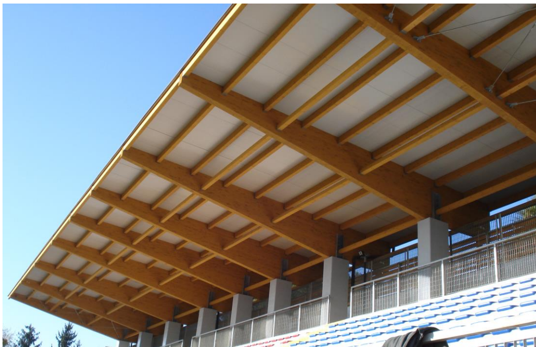
Figura 3: copertura realizzata. Sono individuabili le 9 campate, di cui la prima e l'ultima controventate.
