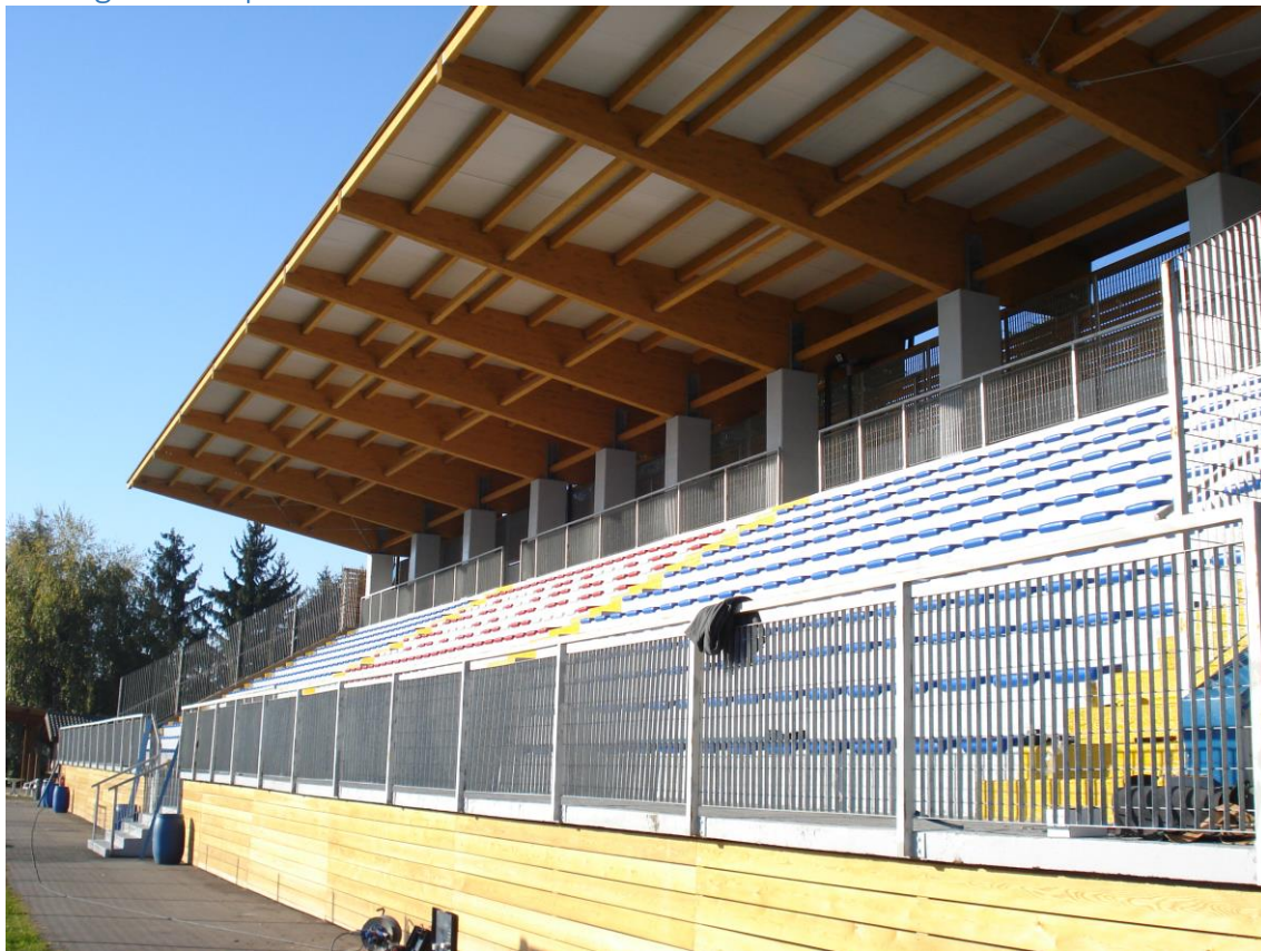
Figura 17: la copertura ultimata.
