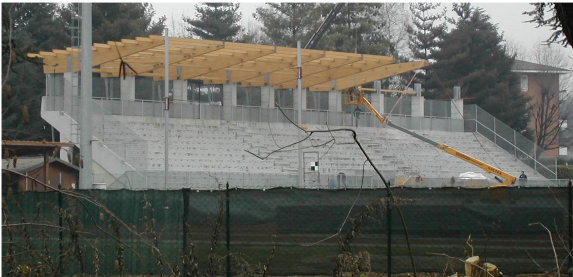
Figura 15: posizionamento degli arcarecci in copertura.
