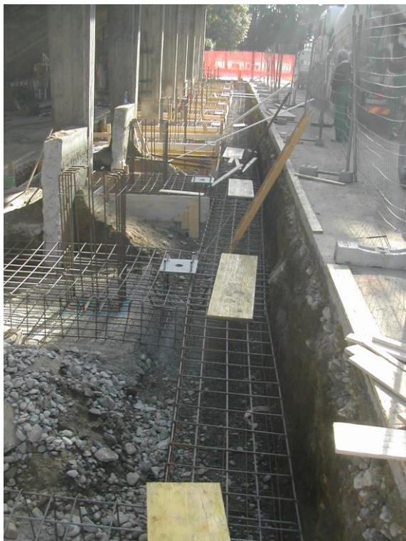
Figura 2: armatura delle fondazioni.
