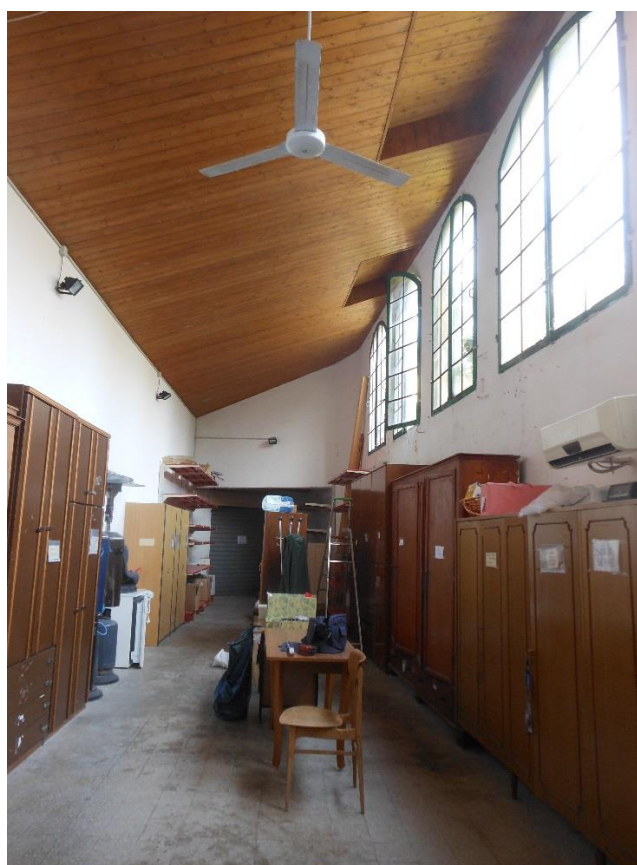
Figura 2 – Vista interna del fabbricato
