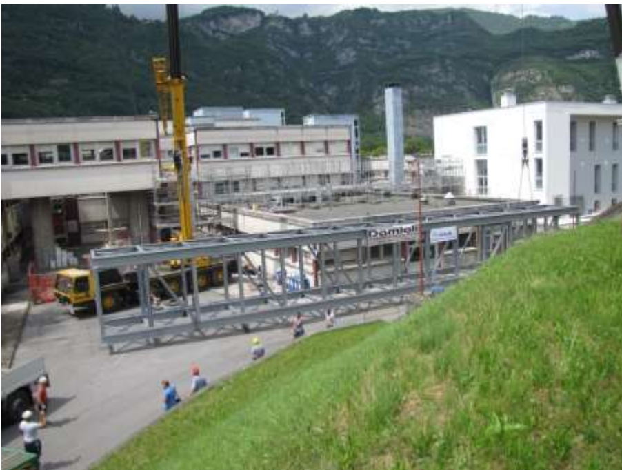
Figura 21: fase di montaggio.
