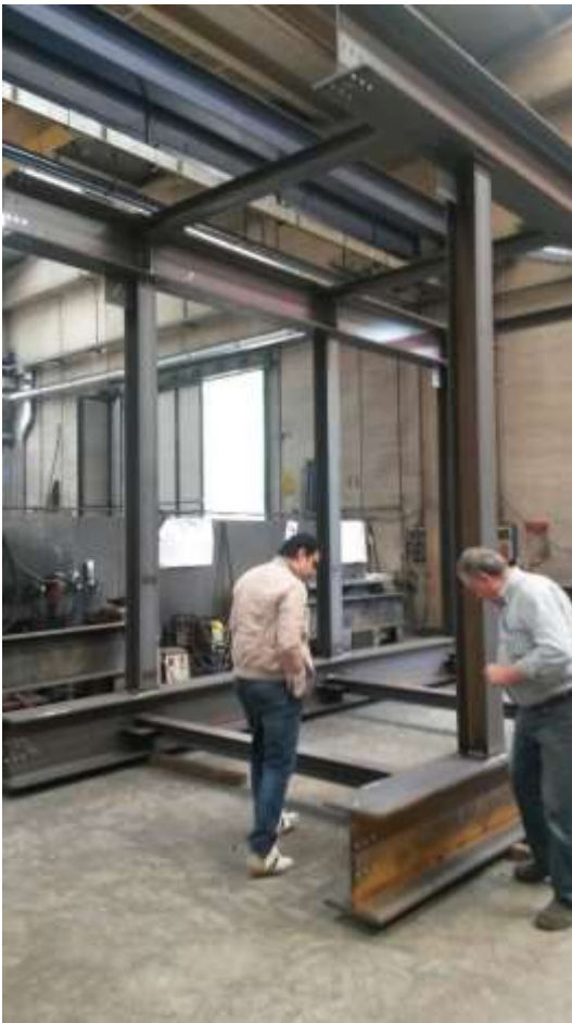
Figura 20: fase di assemblaggio della carpenteria.
