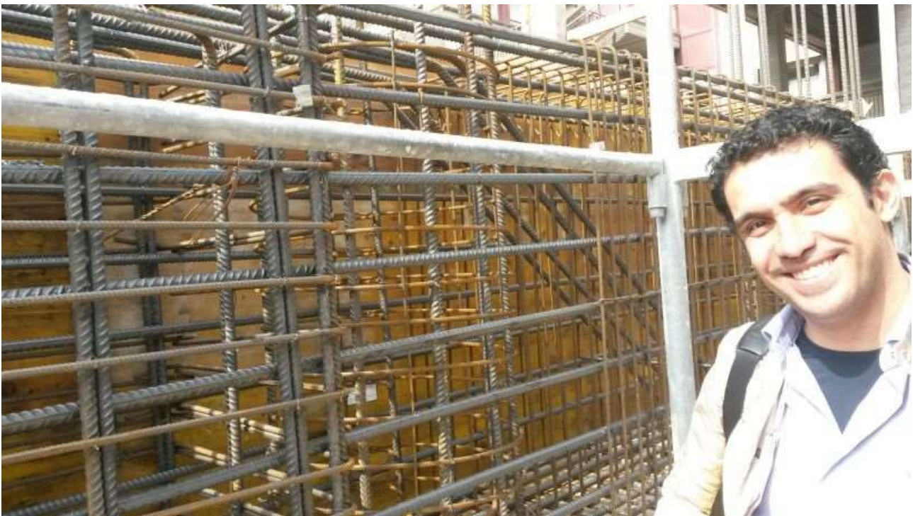
Figura 7: armatura trave di collegamento dei pali.
