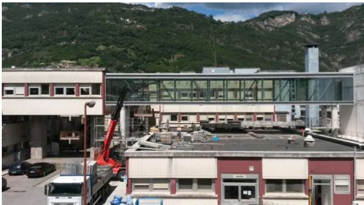
Figura 22: fasi terminali del montaggio.
