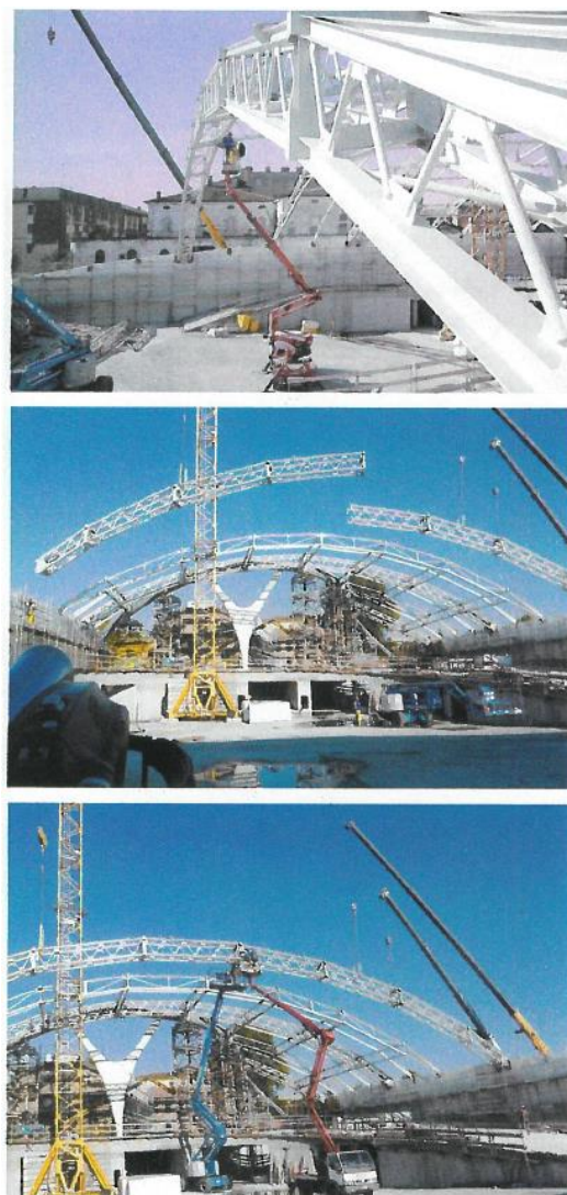
Figura 7: fasi di montaggio degli archi principali.
