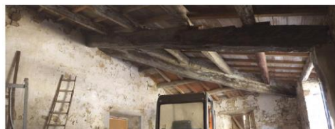
Figura 21: Vista interna della copertura, il sistema spingente delle travi lignee di copertura
