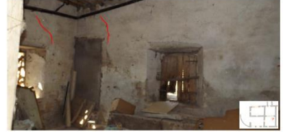
Figura 27: vano sud del locale, aperture presenti nel paramento comune all'annesso
