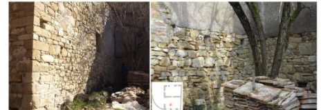
Figura 15: Interno dell'ambiente sud e particolare delle bucatore usate in passato per il soppalco
