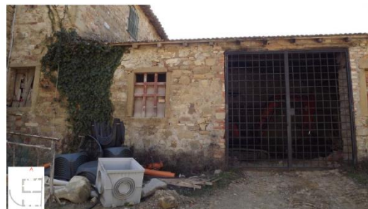
Figura 11: Parte del prospetto nord dell'annesso
