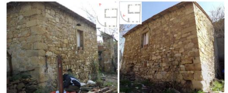
Figura 13: Parete ovest del vano nord vista da due angolazioni differenti
