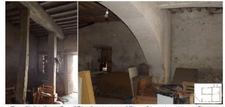
Figura 26: dettaglio puntellatura dell'impalcato, inserimento dell'arco nel paramento ovest comune all'annesso
