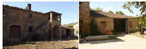
Figura 3: Vista nord dell'annesso e con l'edificio adiacente
