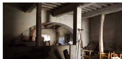
Figura 25: interno dell'ambiente nord del locale terraneo
