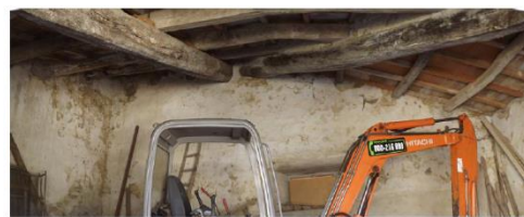
Figura 20: Vista interna della copertura, teste delle travi e degli arcarecci inglobate nella muratura
