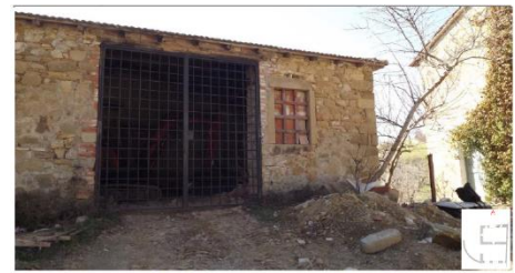
Figura 12: Parte del prospetto nord dell'annesso
