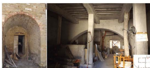
Figura 24: ingresso al terrano del casolare adiacente, ambiente nord del terrano
